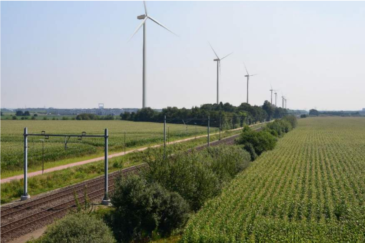
Afbeelding 31 Zicht vanaf het spoorviaduct op de N295 Greenportlane richting het oosten (locatie 3) bij alternatief A. De bundeling van de opstelling parallel aan het spoor is duidelijk zichtbaar.
